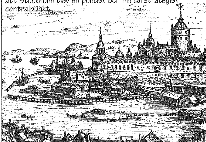
Slottets pålkrans mellan Slottsbacken och Helgeandsholmen. Hogenberg omkring 1585. I förgrunden "Lilla Stockholm", nu till större delen bortschaktad och belägen under Norrbro över norra strömgenen. (Ur Hansson, 1956:289.)
