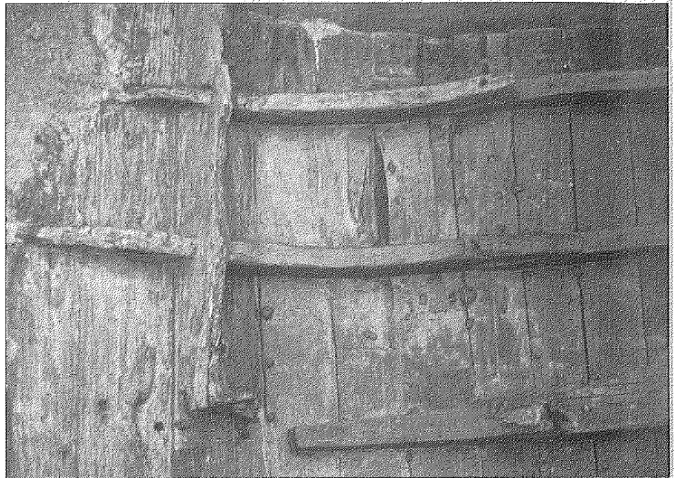
Lodfoto över Galtabäck II, notera mastspantet och vägaren.
