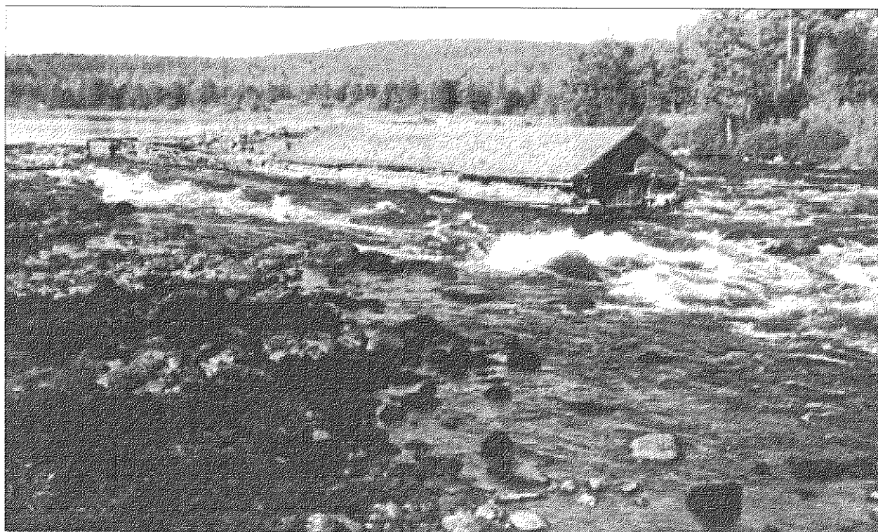
Figur 1. Ålhuset i Aldern, Väster-norrland.
