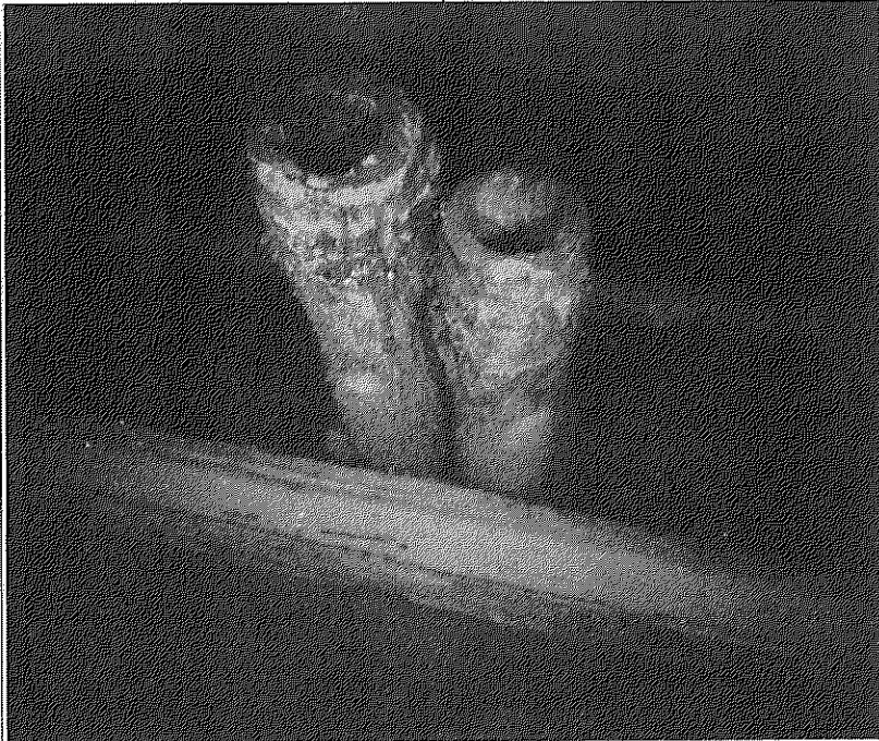
Strax akter om lastrummet sticker två alpumpar upp ur fartygets inre. Det originella med fartygets pumpar är att de sitter mycket tätt placerade. Foto: Torleif Nilsson
