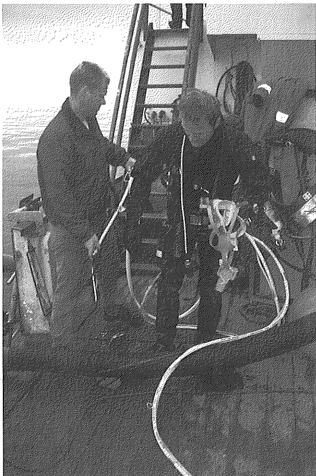
Bild 4 Av säkerhetsskäl, men också som ett sätt att effektivisera arbetet på botten, användes navelsträng och radiokommunikation vid dykningarna.
