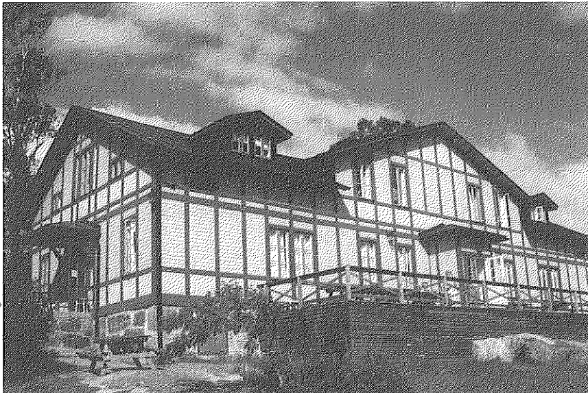
Bild 2 Det gamla kolerasjukhuset (Wasa), byggt 1892. I dag fungerar huset som vandrarhem.
